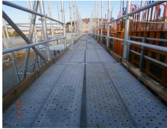
<그림 8> 작업발판 설치 예
